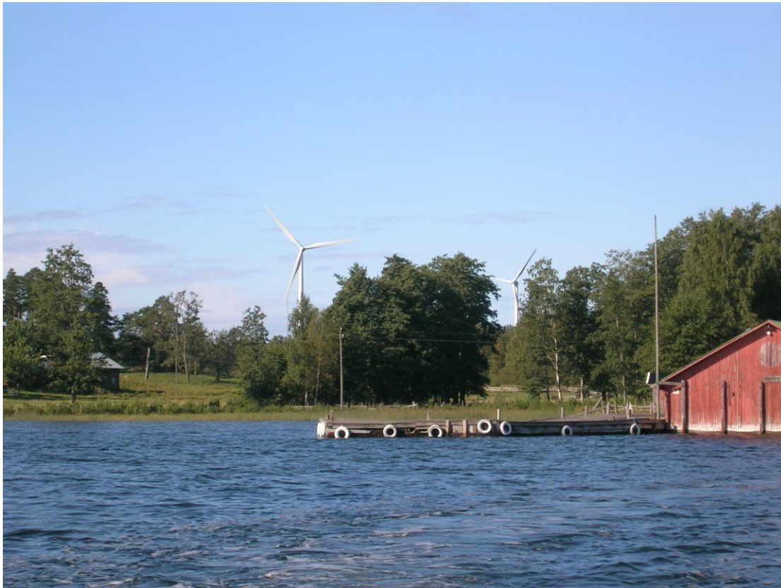
Foto: Högsåra vindpark – Hafmex Wind Oy
