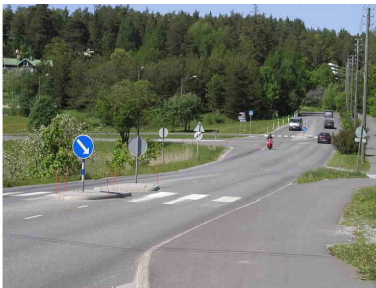
Bild 18 Anslutningen mellan Skräbbölevägen och Pjukalavägen
